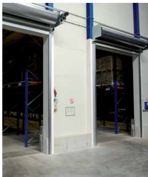
Ruime ADR-bunker De ADR bunker is goed voor 2500 palletplaatsen.
